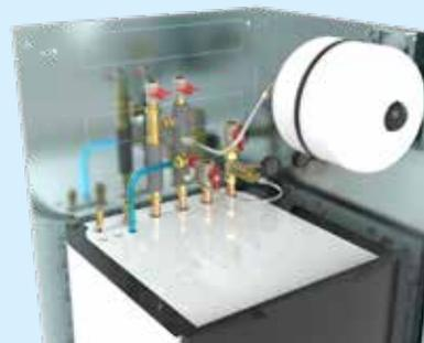
All'interno del Kit sarà presente il manuale di installazione dei vari componenti comprese anche le istruzioni per montare il microaccumulo inerziale e info sulle perdite di carico
